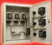
Управление трехзонной печью
